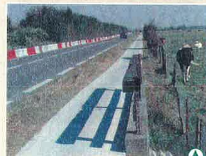
Fond de baie, mise en sécurité
